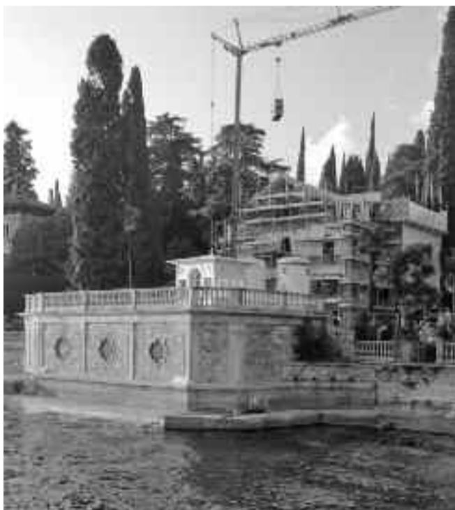
La villa dove sono in corso i lavori
