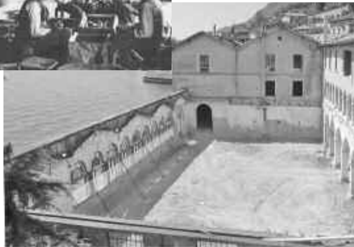
Quel che resta della cernita dopo la demolizione
