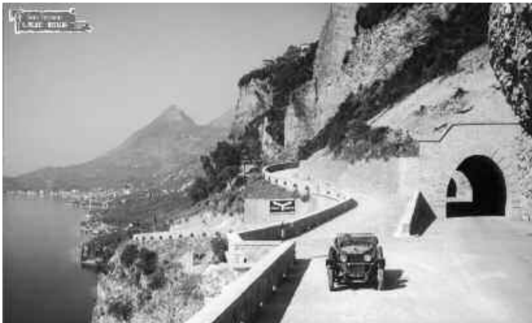
Terza galleria Eutenia, inizio della strada dei Dossi verso Tignale, veduta di Gargnano Dal libro "La strada nella roccia" - Fondazione Negri - pag. 85
