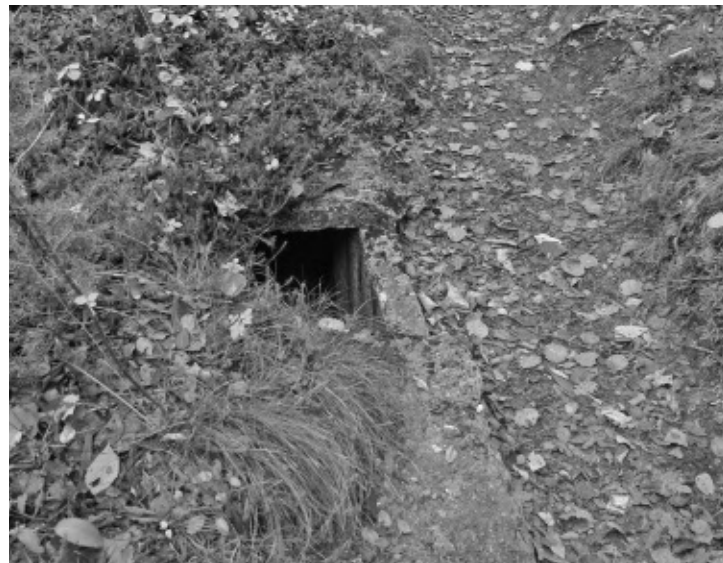
L'imbocco di una trincea in cemento
