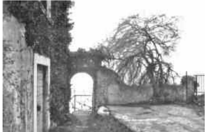
Una vecchia foto prima della sistemazione a spiaggia pubblica
