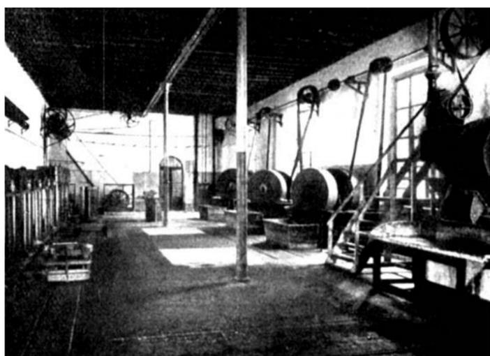
*L'interno dell'oleificio in una foto storica: si possono notare le macchine per la spremitura delle olive e la produzione di olio, le vasche in pietra per la lavatura delle olive e gli orci per la conservazione dell'olio di oliva (da: Erculiani, 1940)*
